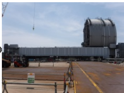
図 11 ドーム屋根側面組立試験
