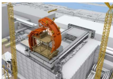
三日月型モジュールを移動式架台に支持させて組立
