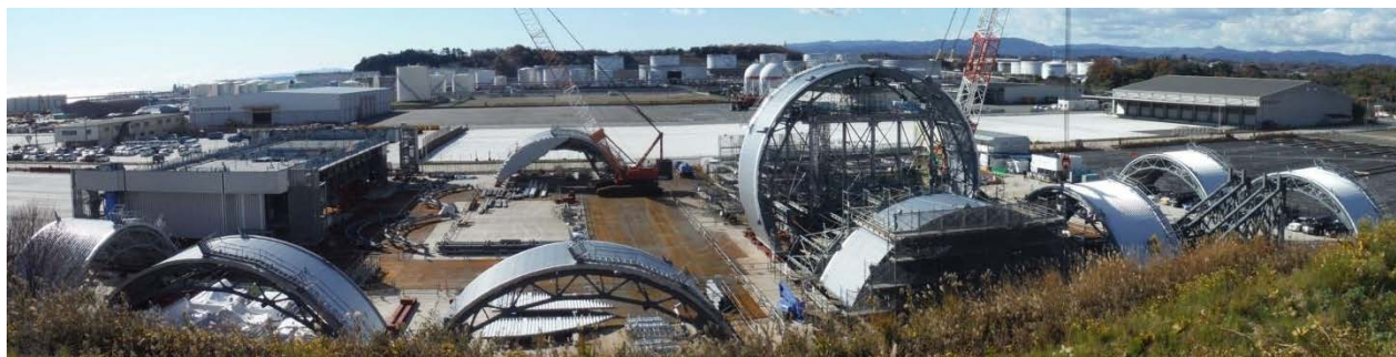
図 6 各種大型ユニット鉄骨のサイト外仮置き状況
