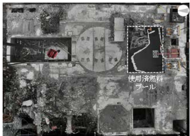
図7 3号機オペフロ大型瓦礫撤去完了後の状況
