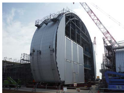
図 11 ドーム屋根側面組立試験
