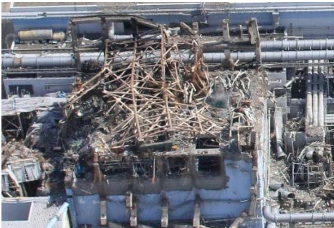
図1 3号機外観(事故当時)
