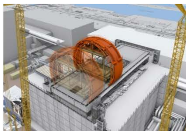
移動式架台でガーダ上をスライドさせドームユニットを所定の位置に据付
