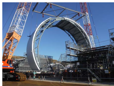
図 10 ドーム屋根合吊り試験
