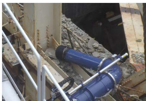
写真 4 小ガレキの吸引状況
