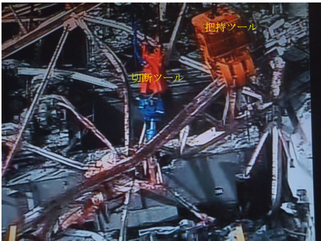
図6 トラス把持切断状況（リモート室画像）
