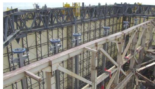
写真 8 ミストノズルユニット設置状況 (東面) (東面 7 箇所、西面 6 箇所)
