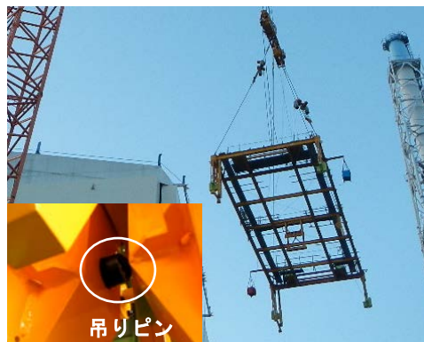
写真 2 屋根パネル吊り治具、自動玉掛装置
