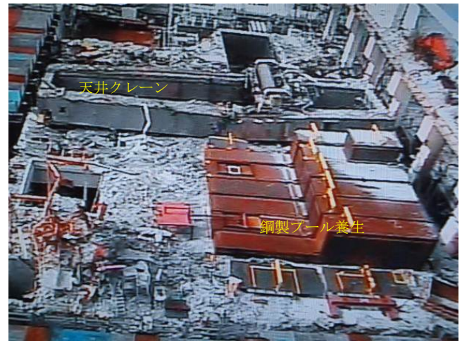
図7 トラス撤去完了状況
