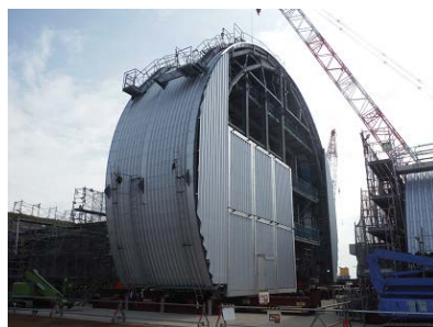
図 11 ドーム屋根側面組立試験
