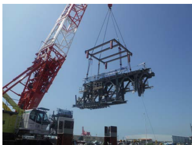
図 8 門型架構ガーダー鉄骨組立試験
