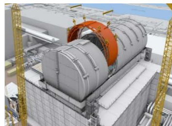
揚重可能範囲内のユニットはクレーンの相吊りにより直接据付
