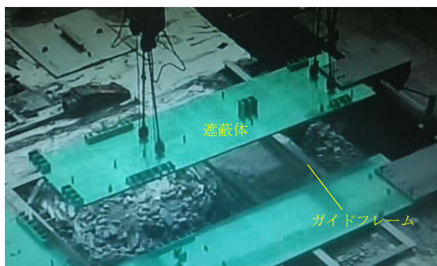
図 16 遮蔽体設置状況(B 工区)
