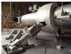
配管耐震補強
