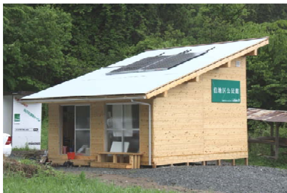
図9 独立型太陽光発電をも応急仮設公民館
