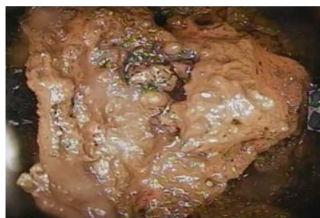
図2 2号機ペDESTAL内堆積物可動性調査
