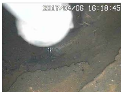
図1 1号機格納容器床の堆積物
