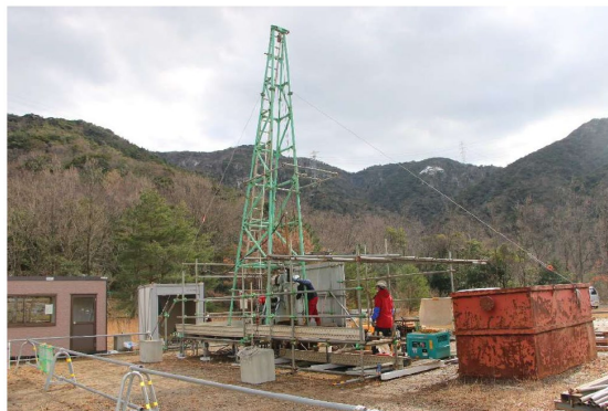
図4 ボーリング作業（2021年1月18日撮影）
