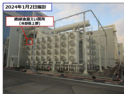
2号機 主変圧器の損傷
