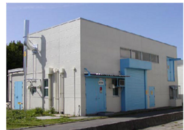
Photo 1 廃水処理室外観
