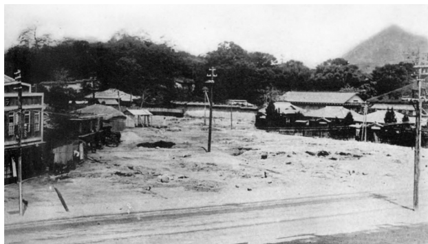
図-1：6号線着工前
