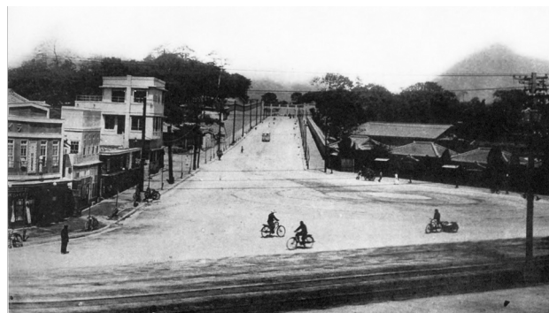
図-2：6号線完成後
