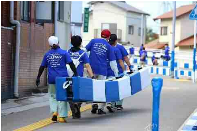
写真 3 安全防護帯設置
