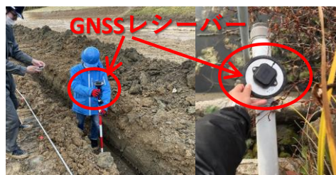
写真2 GNSS レシーバーによる位置情報取得状況
