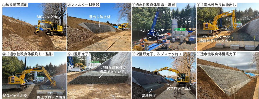
写真2 透水性改良体の施工状況
