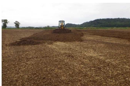
写真-3 不陸整正の施工状況
