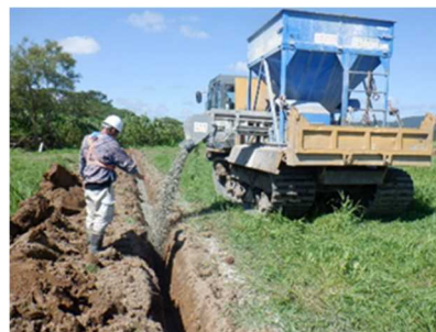
写真-4 暗渠排水溝の疎水材投入状況
