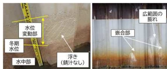
図5 超厚膜形被覆の変状(14年後)
