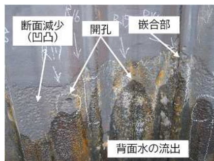
図1 素地調整後の鋼矢板外観（一例）
