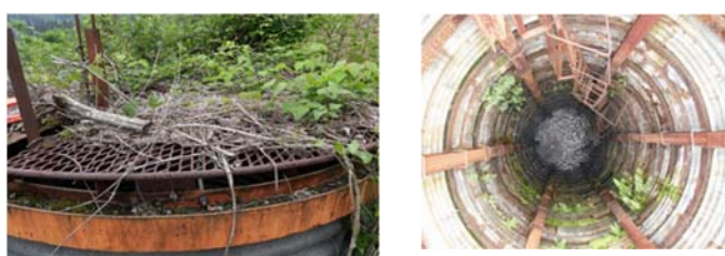
図5 ライナープレート製集水井の天蓋と植生
