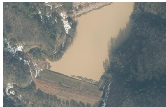
図 2 堤体に亀裂が発生したため池
