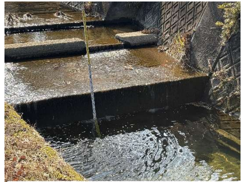
図 2 高さ約 1.5m（水面から約 0.5m）の落差（O 池）
