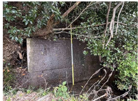
図 3 高さ 2m 以上の鉛直落差（I 池）
