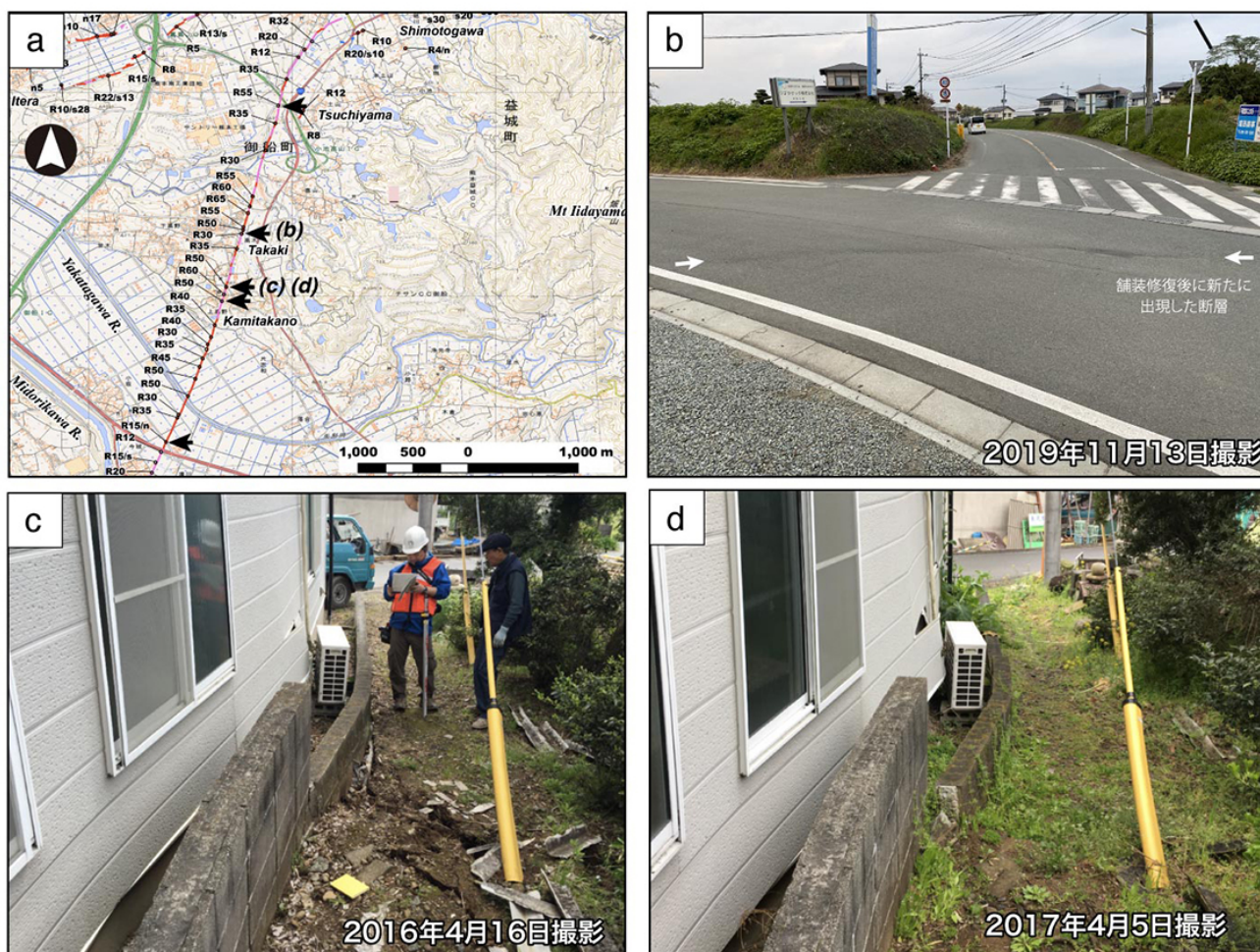
図1. 余効すべりが確認された地点. a)矢印が確認地点. 基図は熊原ほか(2016). b)地震後に修復された路面に出現した雁行亀裂群. c)地震直後のブロック塀の変位, d) 1年後のブロック塀の変位.
