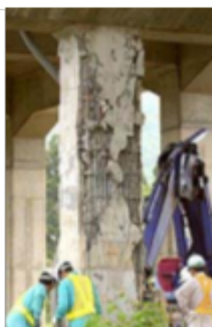
(a)被災位置図（三陸南地震,2003）(b)被災状況 図4 橋脚被害の発生位置と被災状況
