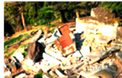
熊本地震 (2016, M6.5, M7.3), 石碑【約 3tf】は 5.8m 程飛翔 図 3 慰霊塔施設 飛散状況
