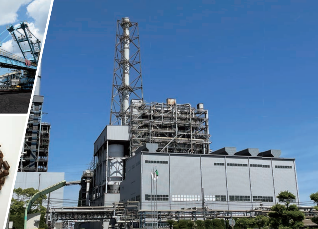
216MW 発電設備
