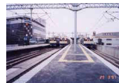
復旧工事完了後、1両100tの機関車が 2両編成で一団となって4線を並走する 総重量800tの載荷試験を実施
