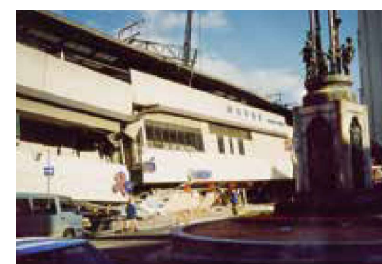
倒壊し1階コンコースがつぶれた状態の JR六甲道駅
