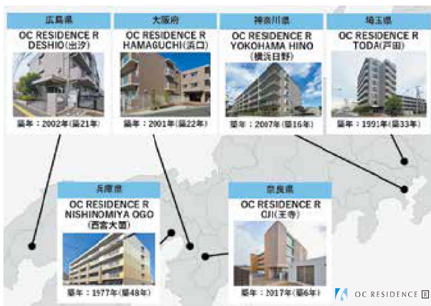
全国に6棟ある「OC RESIDENCE R」
