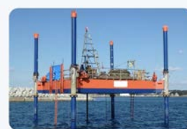
海上ボーリングの実施状況
