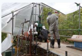
ボーリング孔における原位置試験状況
