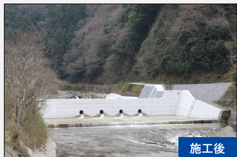
砂防堰堤復旧設計
