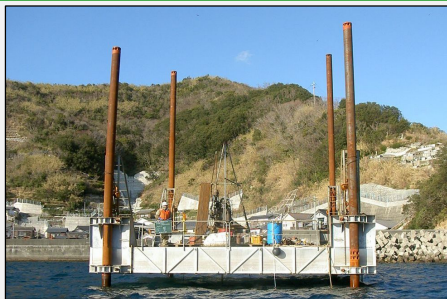
海上でのボーリング調査
