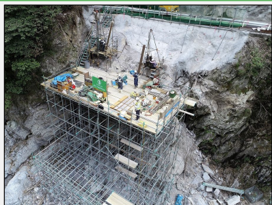
急崖でのボーリング調査
