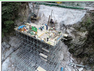
急崖でのボーリング調査
