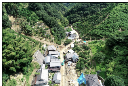
H30豪雨_土石流災害(宇和島市)
