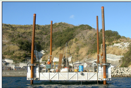
海上でのボーリング調査
