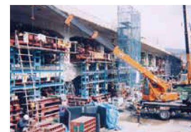
ジャッキアップ工法による復旧工事
