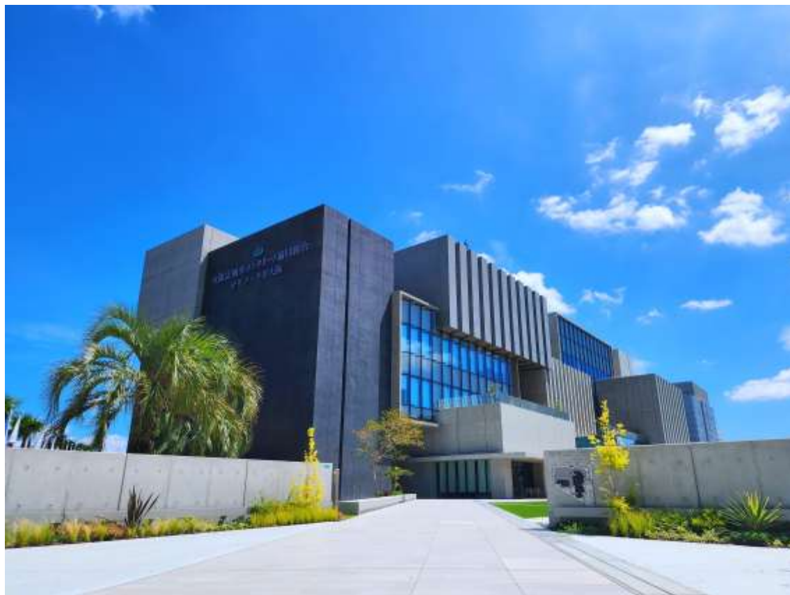
大阪広域生コンクリート協同組合 自社ビル（テクノ・ラボ大阪）の外観
