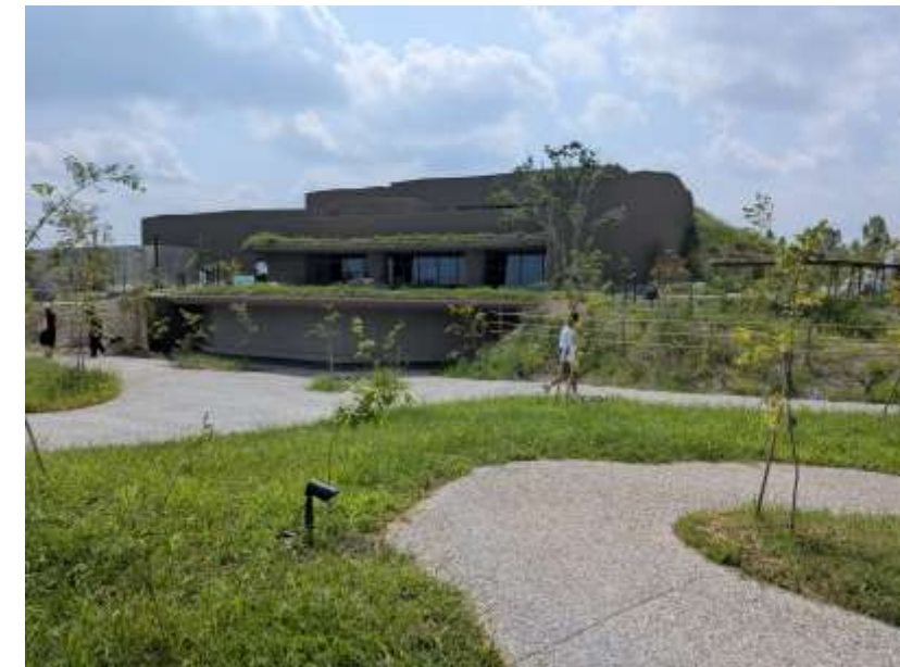
完成後の大津湖岸なぎさ公園
