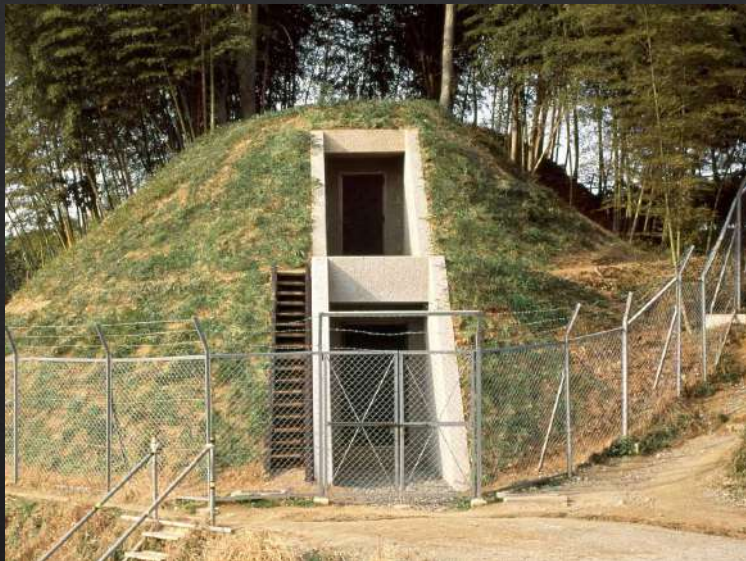
1976年（昭和51） 保存施設の完成 1階コンクリート現場打ち 2階PC版
