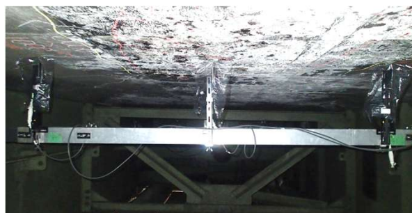
(変位計設置状況)
