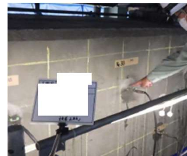
(亜硝酸リチウム注入状況)
