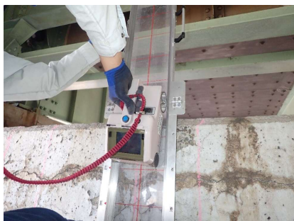
(磁気法の作業状況)
