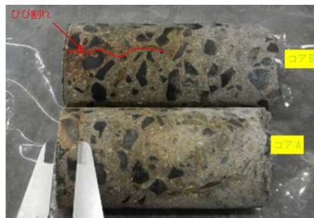
(亜硝酸リチウム浸透度測定状況)
