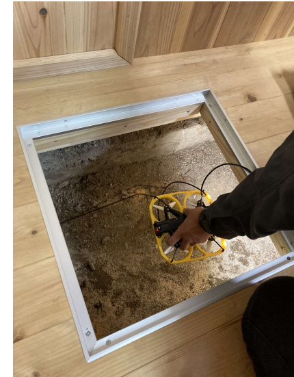
写真 開口部より機器挿入
