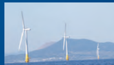
洋上風力発電(長崎県)
