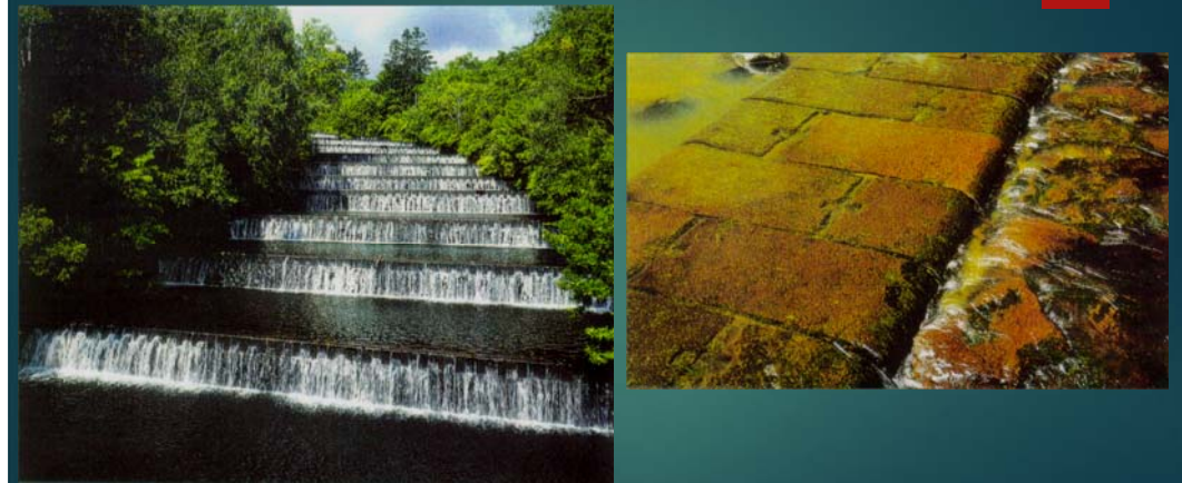
图4-1 小樽水源貯水池余水吐
