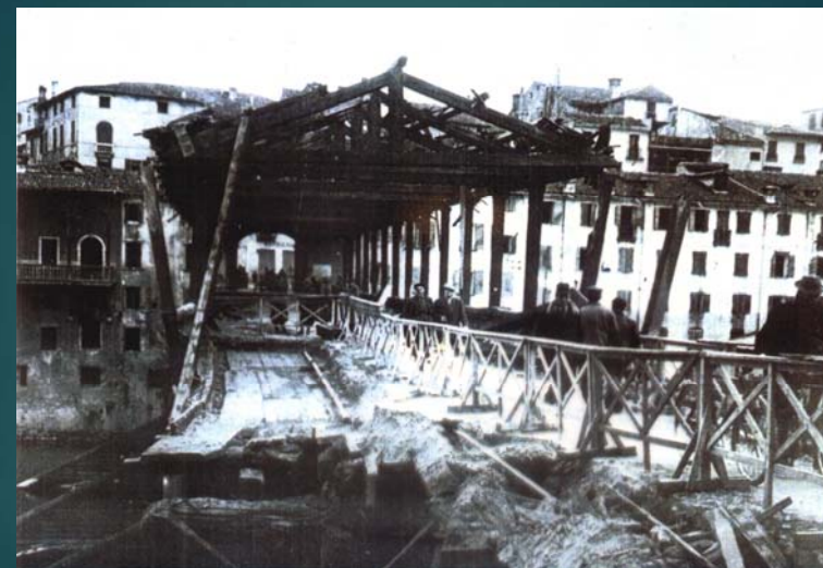
図5-3 ドイツ軍に破壊された橋
