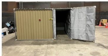
角波鉄板スパッタシート囲作業室
